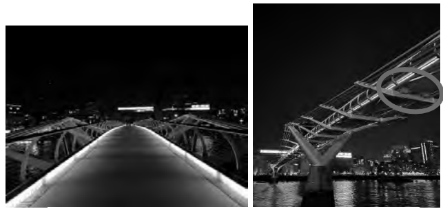
図 21 ミレニアム・ブリッジ (左：橋の上，右：赤○がダンパー)
