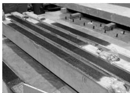
(b) PC はり下面に接着された連続繊維シート
