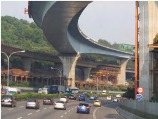
写真 5 長大スパン部で使用する鋼箱桁
