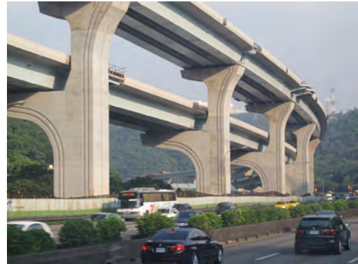
写真 6 F 字型の橋脚
