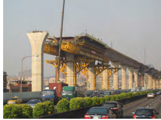
写真 4 一般部の PC 桁の架設
