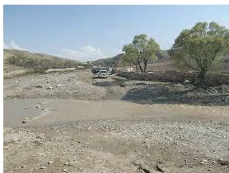
川により遮断される道路
