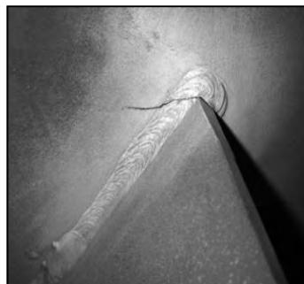
図 7 垂直補剛材上端部の疲労き裂
