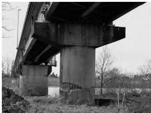
写真 10 主鉄筋段落し部で破壊した藤橋
