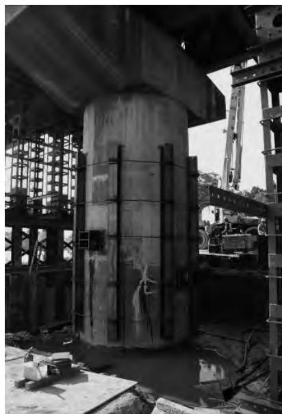
写真 11 H 型鋼により緊急対策
