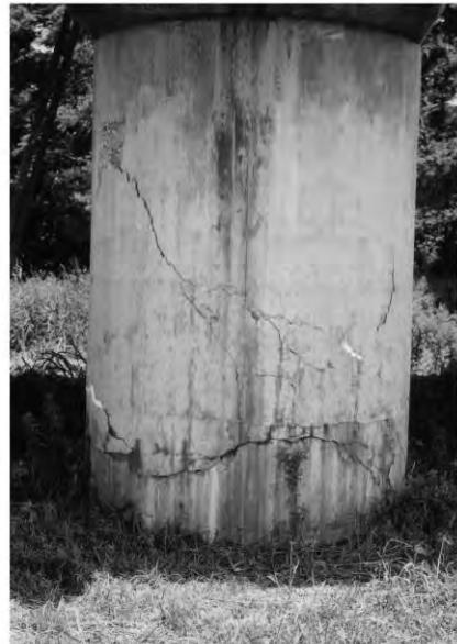
写真7 桁端を支持する橋脚のせん断クラック(1978年宮城県沖地震)
