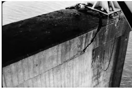
写真4 落橋寸前であった支承下橋脚頂部の被害(1978年宮城県沖地震)
