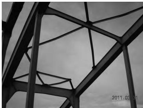
写真6 破断や座屈が生じたトラス上横斜材
