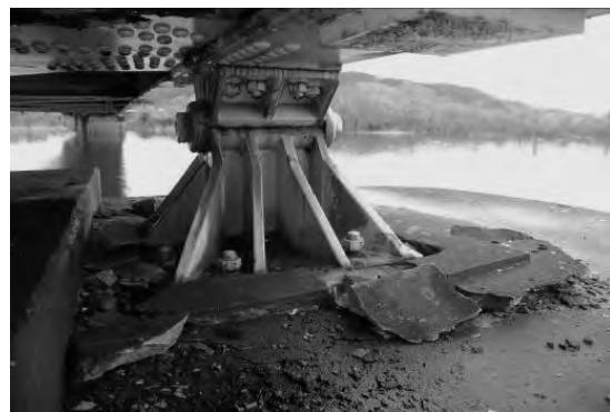
写真5 ピン支承固定部の被害
