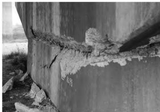
写真1 P6 の被害(1978年宮城県沖地震)
