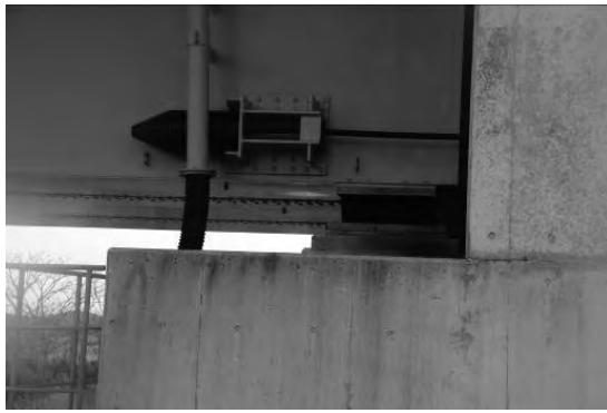
写真 12 積層ゴム支承と落橋防止構造
