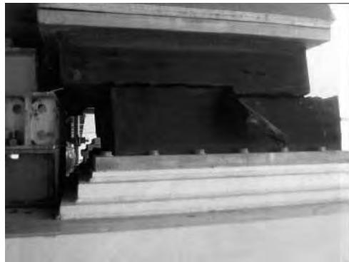
写真 14 積層ゴム支承の橋軸直角方向への破断(NEXCO 東日本提供)
