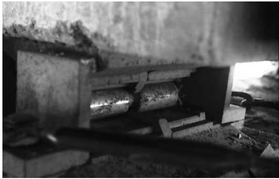
写真 8 ラーメン橋脚端部のローラー支承
