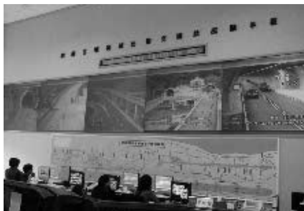
写真-4 雪山トンネル管理センター
