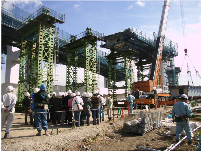
写真2 東有明 JC 高架橋工事現場でボックスガダーの架設方法について説明を聞き、その後、奥の桁に登り工事現場全体について説明を受けた。
