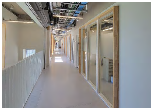
西 6 号館 4 階 廊下 手前は建築研究室
