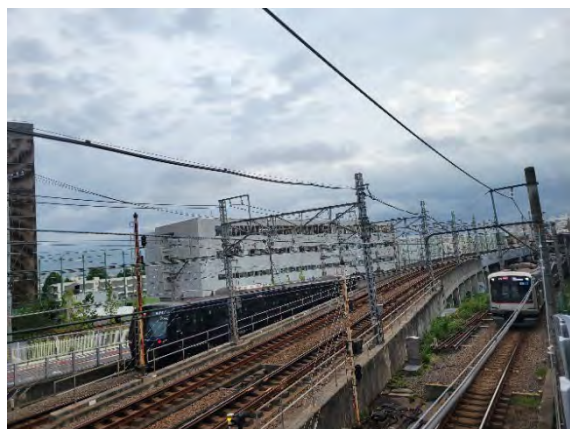
西6号館 ロマンス坂の途中から
