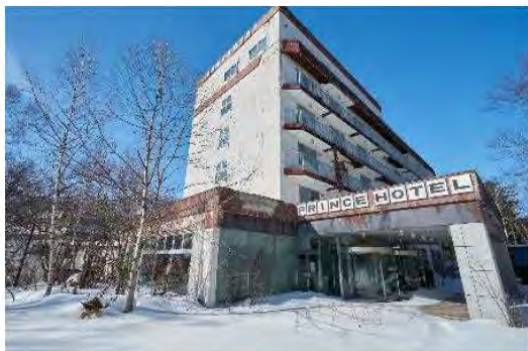
放置された廃屋（撤去済み） 1
