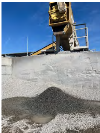
再生骨材工場
