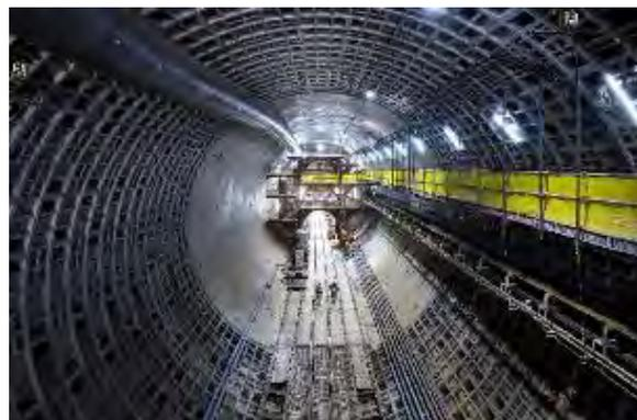
大泉南行きトンネル坑内と構築中の後続設備
