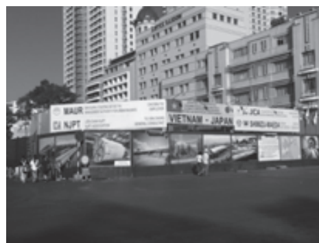
図 3 ホーチミン地下鉄の建設現場
