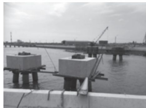
図7 栈橋(杭が斜めになっている)
