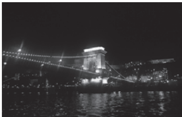
船上から見たくさり橋
