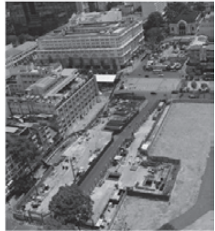
写真-3 オペラハウス駅建設現場全景
