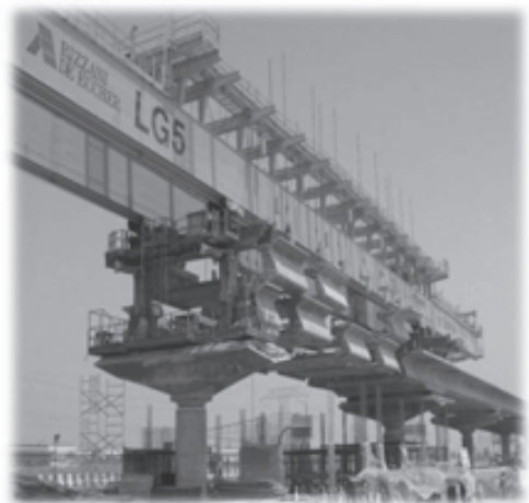
写真-5 架設桁による主桁架設
