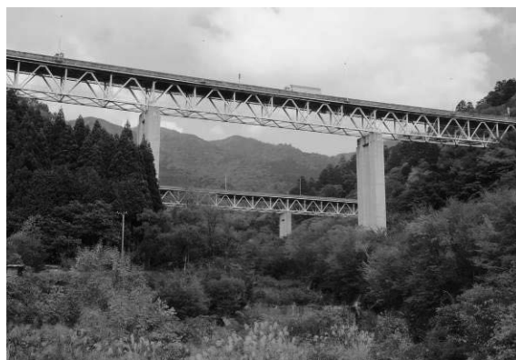
橋梁振動を用いた発電技術の開発
