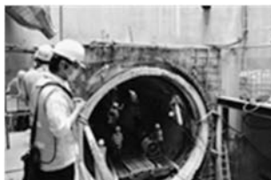
写真 17 トンネル端部
