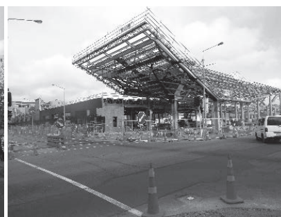
図 14 建設中の建物
