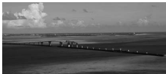
沖縄離島橋梁の全景
