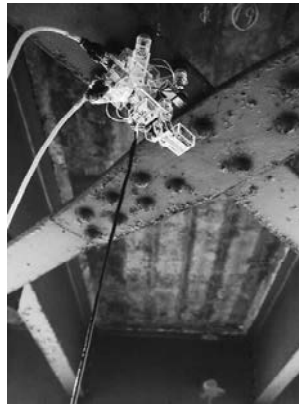
点検中の様子
