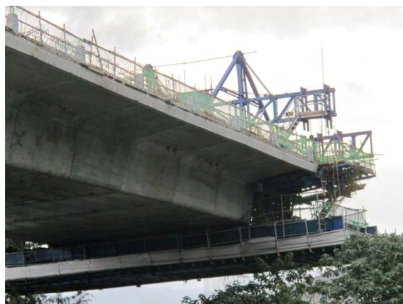
写真 8 張出し架設中の PC 箱桁
