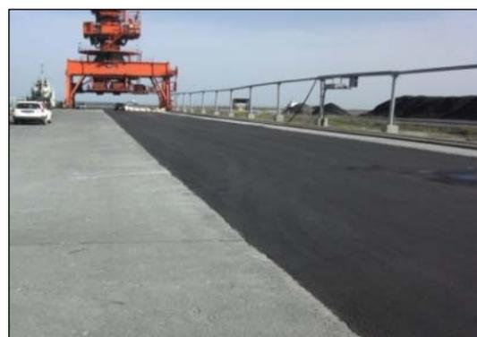
アスファルト舗装で応急補修
