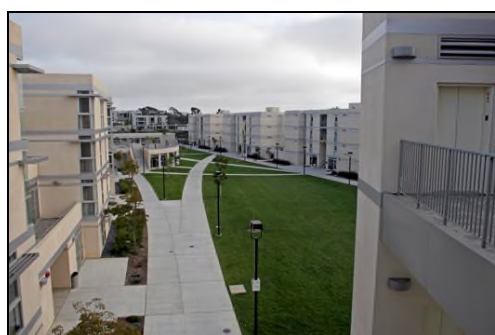
留学生寮の外観
