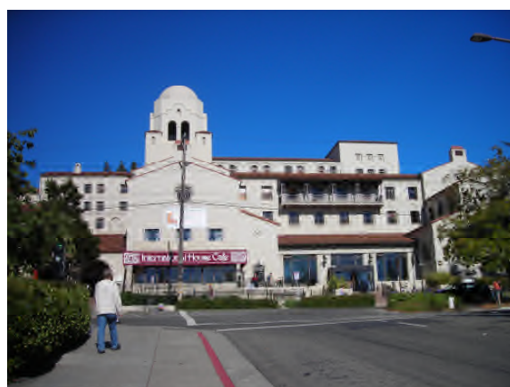
写真 2 寮(International house)の外観
