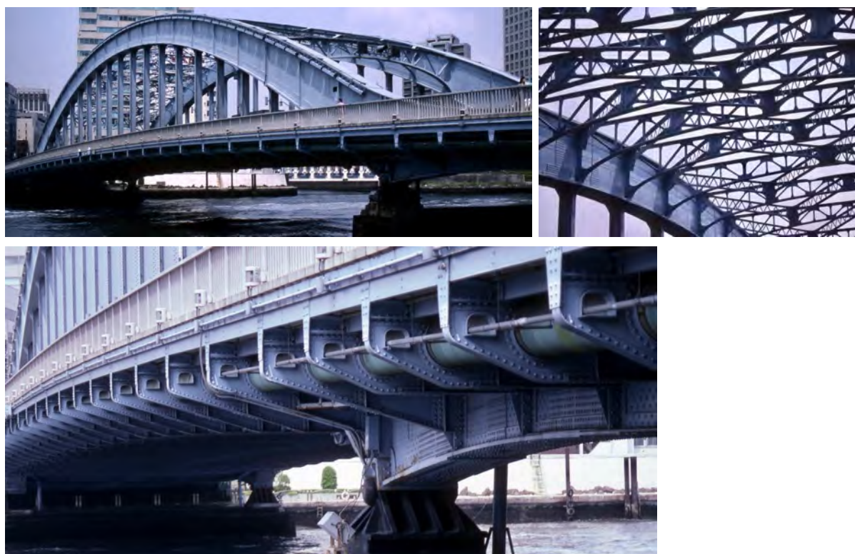
図 5 永代橋 力学的合理性の所産だが、構成部材が装飾的な効果をあげていることに注意
