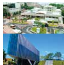
上:東工大蔵前会館 下:附属図書館
